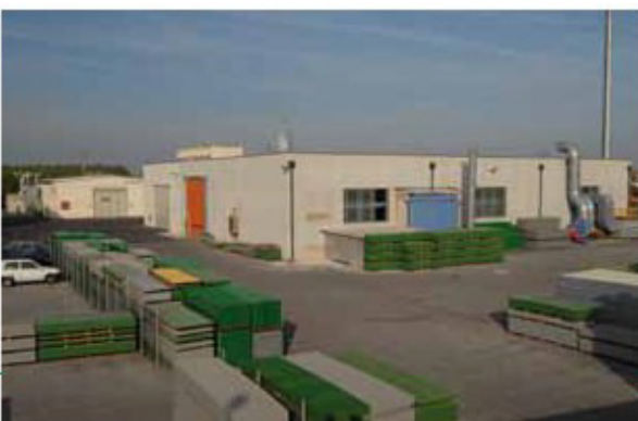
Armazém temporário de gradil
