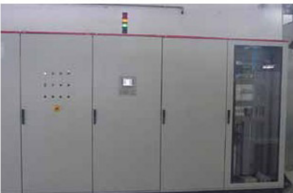
Controle de moldagem com PLC
